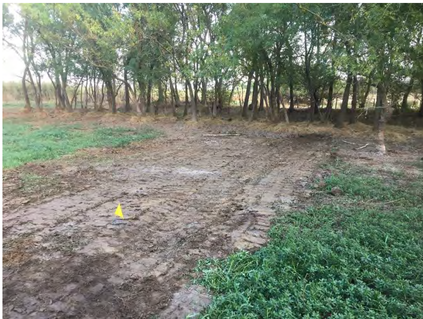
Photo 52. Sondage GAL3-5_T8N rebouché
