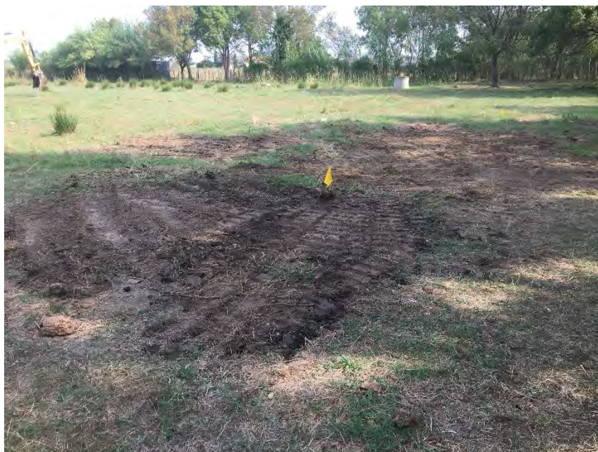
Photo 26. Sondage GAL3-5_S13 rebouché
