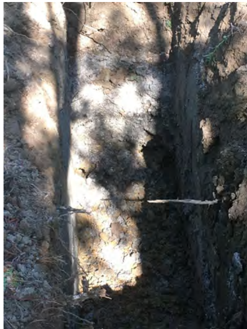
Photo 43. Sondage GAL3-5_T6N (rebouchage au fur et à mesure, non tenue des parois de la tranchée)
