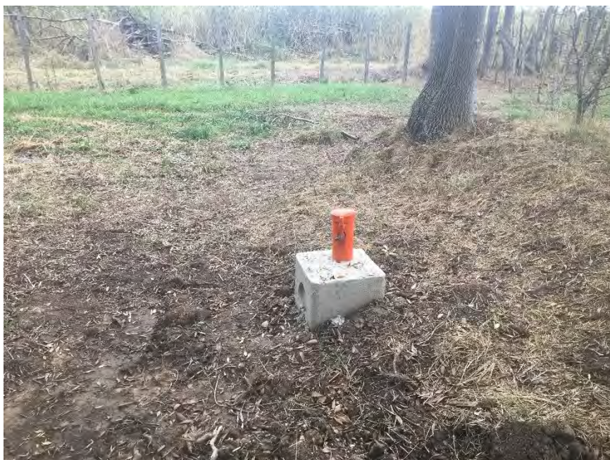
Photo 74. Piézomètre GAL3-5_ MW2
